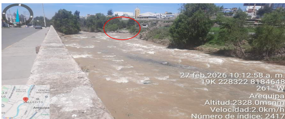
FIGURA N°03: SE OBSERVA PARTES DEL COLMATADO AGUAS ABAJO SE ENCUENTRA LA ALTURA DEL MURO DE CONCRETO DISMINUIDA POR EL MATERIAL DE ARRASTRE Y TAMBIEN SE ENCUENTRA EN RIESGO AGUAS ABAJO LA BOCATOMA CREPIAL COMO SE OBSERVA EN EL CIRCULO ROJO
