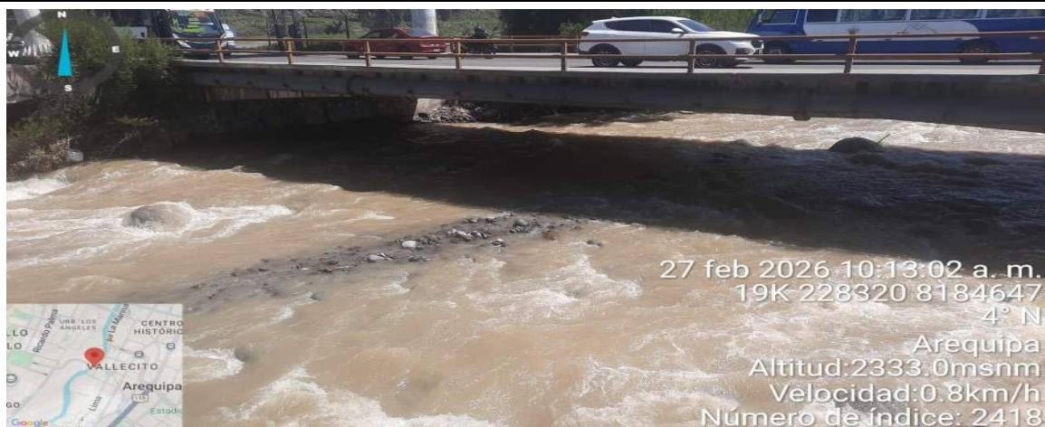
FIGURA N°01: TRAMO CRÍTICO EN EL RIO CHILI COLMATADO POR EL EJE DEL CAUCE DONDE AGUAS ABAJO EL AGUA REBALSA EL MURO DE CONCRETO ARMADO
